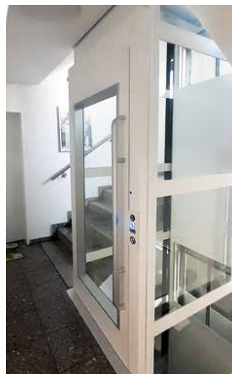
Nach dem Einbau des Liftes und der Handläufe
